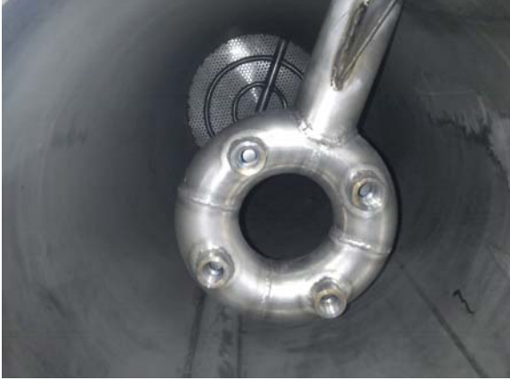
Vedere din interiorul capsulei de presurizare (la partea inferioară – planul depărtat - se observă sistemul de aerare, iar la partea superioară se afla în lucru sistemul de alimentare cu apă)
