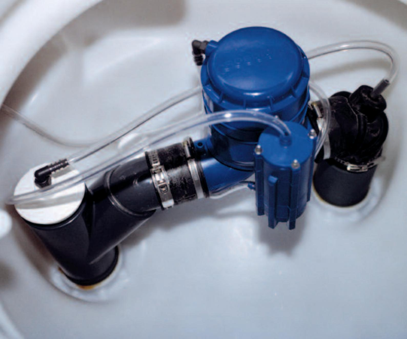
Sus: valva de vid (tip diafragma) ROEVAC cu diam. 65 mm, inclusand controlor activat pneumatic (in fata) si calota cu sensor (alb) instalat intr-o camera de colectare.
